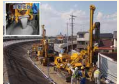
狭隘地での施工状況と流動化砂
