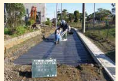
道路、駐車場を平常時は耐震・長寿命化を図り有事のときは液状化を軽減する技術
