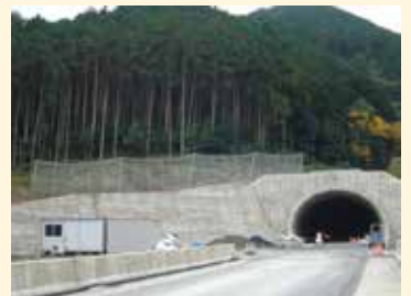
紀勢国道事務所 三木里 トンネル坑口
