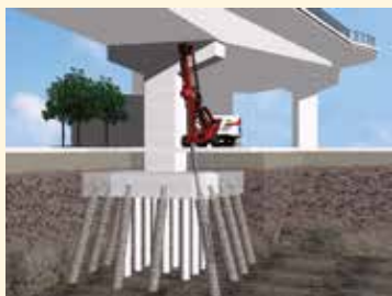
橋梁基礎の耐震補強
