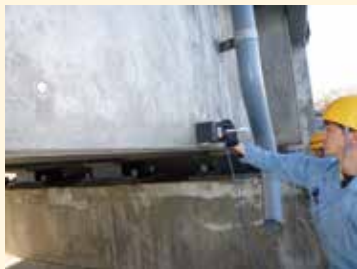
コンクリートビューによる測定状況
