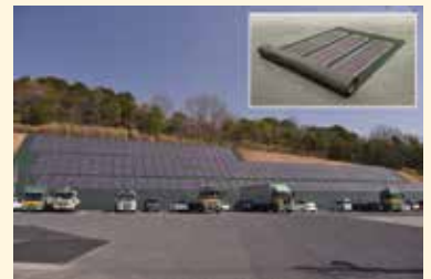
【施工事例】道路災害復旧工事 一般県道田島公園線
