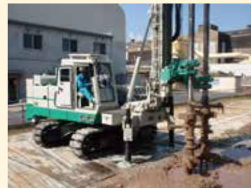
戸建て住宅地対応の小型二軸機による施工状況
