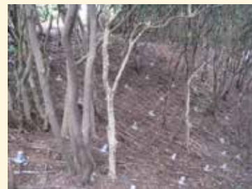
愛知県知多郡南知多町師崎地区でのユニットネット工法施工写真
