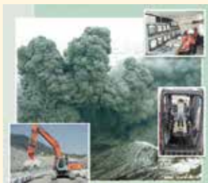
有珠山噴火と無人化施工による災害復旧工事
