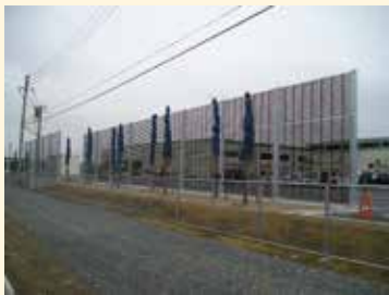
市場の防風対策 高さ5.0m、自立型
