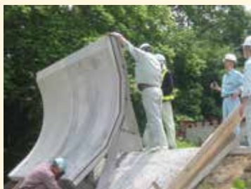
波返し傾斜堤プレキャストブロック(新造)試験施工
