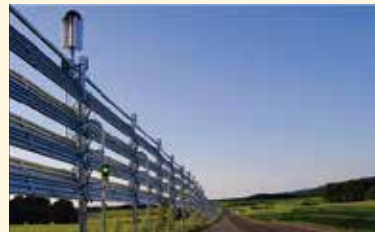
設置事例(秋田県にかほ市)
