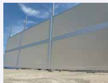
建築用吸音パネル設置例
