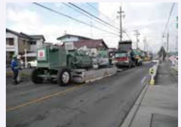
岐阜県多治見市内県道舗装修繕状況(平成23年1月施工)
