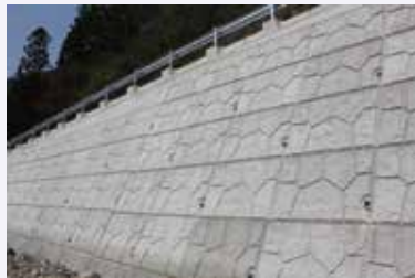
大型積ブロック(ジャストウォール)施工写真
