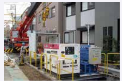
岐阜市内の住宅地内施工状況
