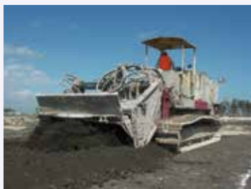
宮城県名取市での防潮堤建設工事(津波堆積土の再利用)
