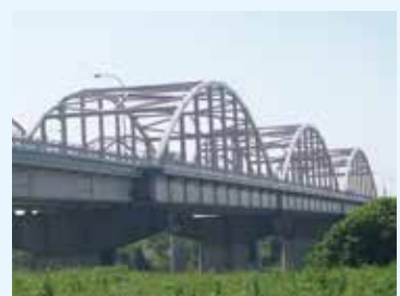
刀水橋(利根川)に掛かる群馬県と埼玉県を結ぶ橋の塗替で採用
