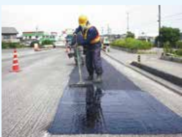
ラバファルトを液状に溶かし、ゴムレイキで塗布作業状況
