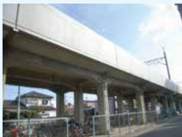
鉄道高架橋補強工事
