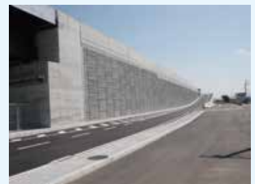
23号木道北道路建設工事(中部地方整備局発注)
