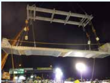
西名阪自動車道御幸大橋(下り線)の床版取替え
