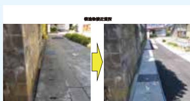
12mを1日で施工完了!
