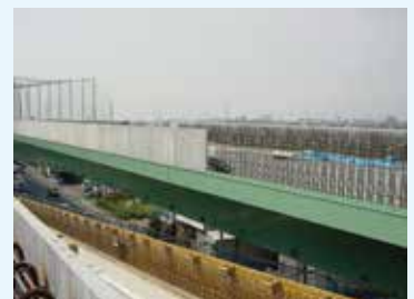
PCF壁高欄工法の施工事例(奥)、手前は従来の型枠工法
