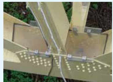
実際に設置されたカバーの状況。格点の内部が明視できる。
