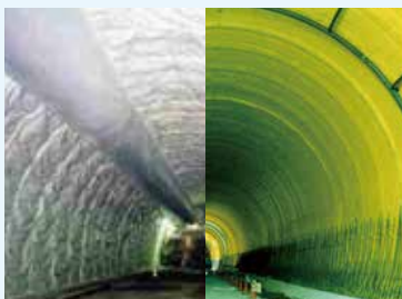
従来工法で張られたシートと本工法の比較
