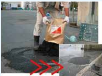
タックコートなどのプライマーは不要、敷き均して転圧するだけ!
