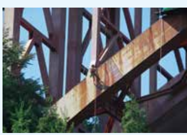
中央自動車道 落合橋
