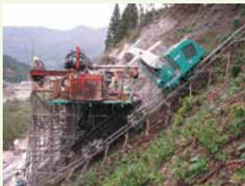
3t掘削機を作業構台上に水平ダンプ
