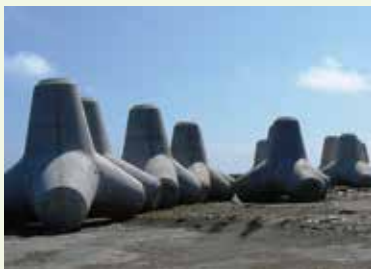
電気炉酸化スラグ骨材を用いた消波ブロック
