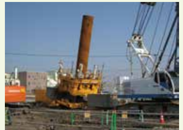
斜杭施工状況写真
