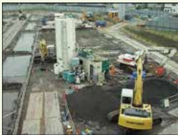
工事現場内で連続ミキサーによって連続処理を可能としている
