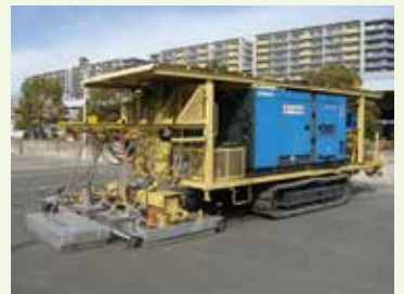
IH式舗装撤去工法の加熱機(クローラ式)
