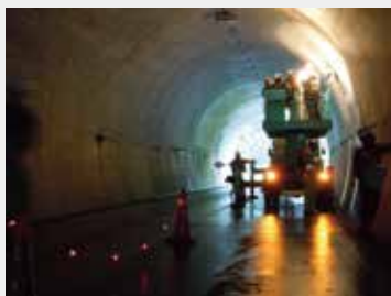
ME養成講座でのトンネル点検実習の様子
