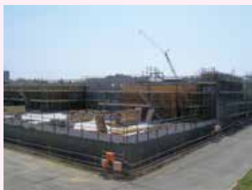
新設配水池表面保護
