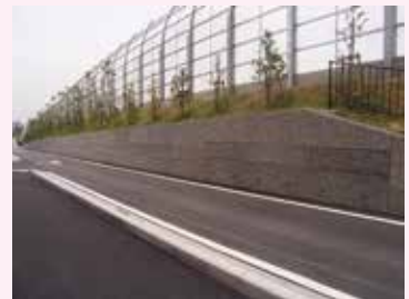
302号乗鞍神沢地区整備工事(名古屋市緑区地内)
