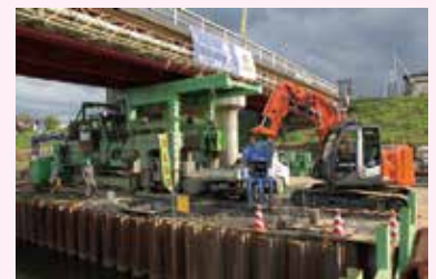
福島県・橋梁拡幅工事 車両が橋の上を通行したまま工事が可能
