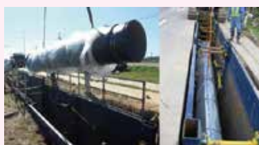
実際の現場写真
