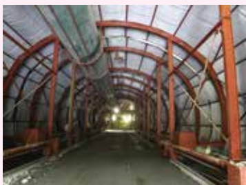
H23古里第1トンネル(中部地整)で適用した加温・加湿養生
