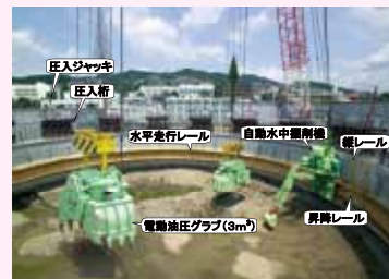
都市部における一時雨水貯留施設(20,000m³)の施工状況
