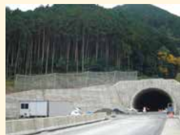
紀勢国道事務所 三木里 トンネル坑口
