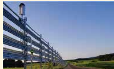
設置事例(秋田県にかほ市)
